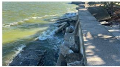
b) Đê biển Hải Tiến (Thanh Hóa) bị sóng biển làm lún, nứt vỡ (nguồn: https://congly.vn/ )
