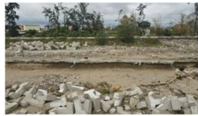
c) Đê biển Hội Thống (Hà Tĩnh) bị bão làm xói lở (nguồn: https://kienthuc.net.vn/ )
